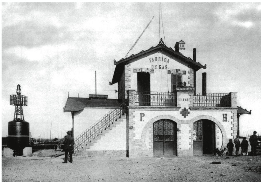
Figura 7. Museo Arqueológico de Huelva.- Edificio de La Fábrica de Gas en 1913. En este edificio se instaló el Museo Arqueológico Provincial en 1946. Según Martín Rodríguez y Prados Pérez, 2006: 102.
